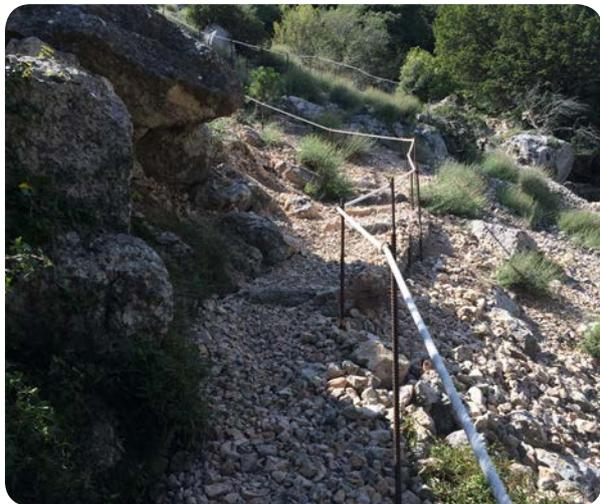
Figura 3. Acondicionamiento de sendero con una malla baja (altura de 30 cm) de acero galvanizado de triple torsión, que pasa por la parte inferior del firme rocoso y anclada con hilo de acero galvanizado en las barras de la barandilla aguas arriba. Tejeda de Cosp (Serra de Cardó). Foto: Jordi Camprodon.
